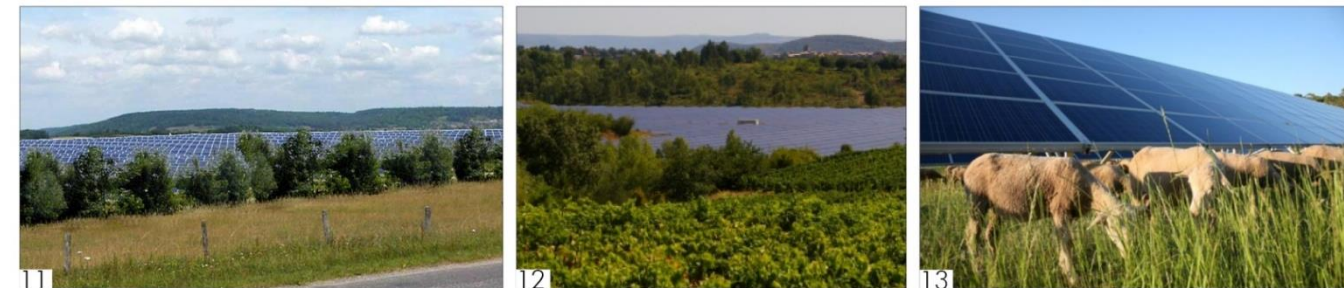
11 12 13 Exemples d'insertion paysagère multiple : de gauche à droite, haie champêtre de réduction des vues, respect de la trame et des motifs agro-paysagers, pâturage sous panneaux.
